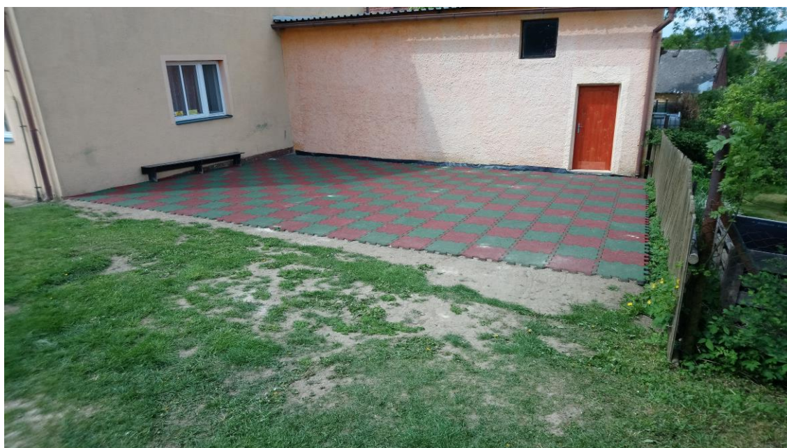
Protipádová pryžová dlažba na školní zahradě
