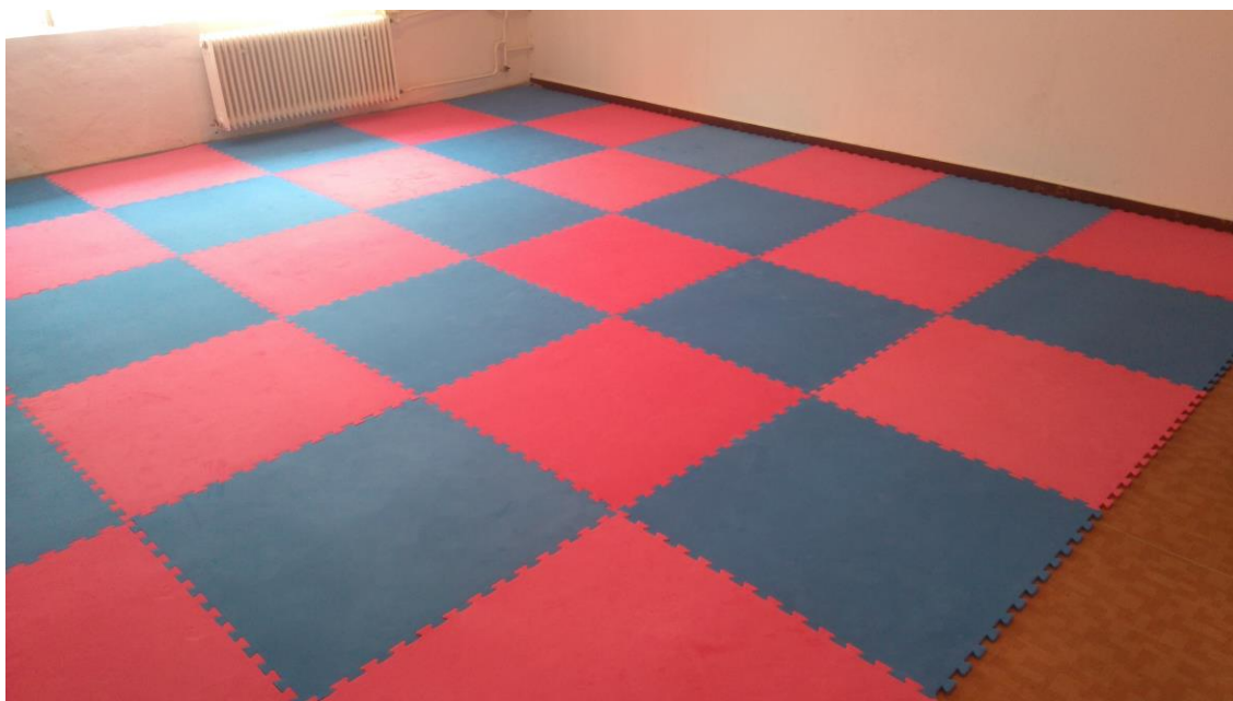
Tepelně izolační podlaha v tělocvičně v budově čp. 1
